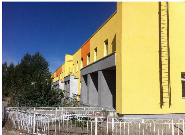
Abb. 3 Krankenhaus kurz vor der Fertigstellung der Bauarbeiten
