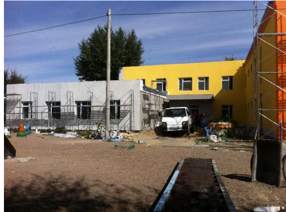
Abb.2 Kindergarten während der Sanierungsarbeiten
